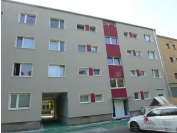
Atum-Saniertes Haus im Fertigzustand
