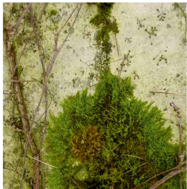
Bild 8: Moosbewuchs (ein Kurzbüchsenmoos, Brachythecium sp.) an einer Wand, die von Wildem Wein ( Parthenocissus tricuspidata ) berankt wird. [© Fraunhofer-Institut für Bauphysik Holzkirchen]
